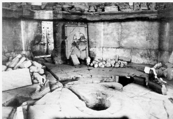
Interior of octagonal tower with doorway to cylindrical water tower at left Innenraum des Turms mit oktogonalem Grundriss. Links im Bild, der Blick auf den Übergang zum zylindrischen Wasserbehälter
