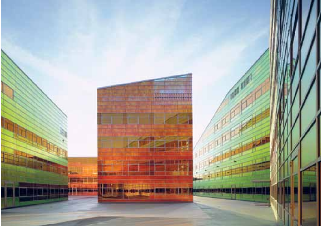
Fig. 10 UN Studio, La Défense Offices, Netherlands, 1999–2004.
